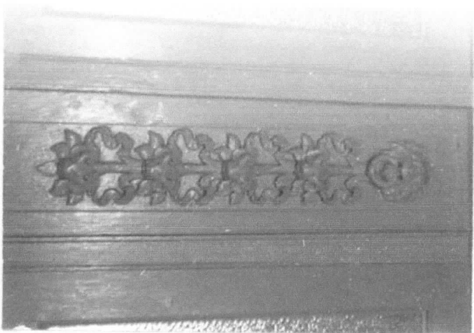
fot.24 fragment drzwi do główniej sali parteru
