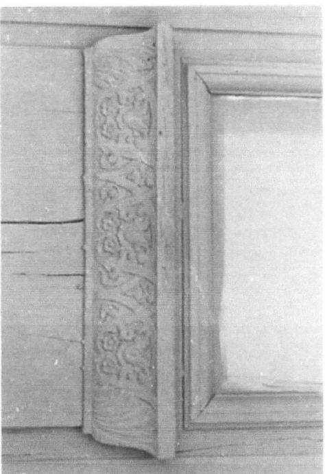
fot.25 fragment drzwi wejściowych w portyku głównym
