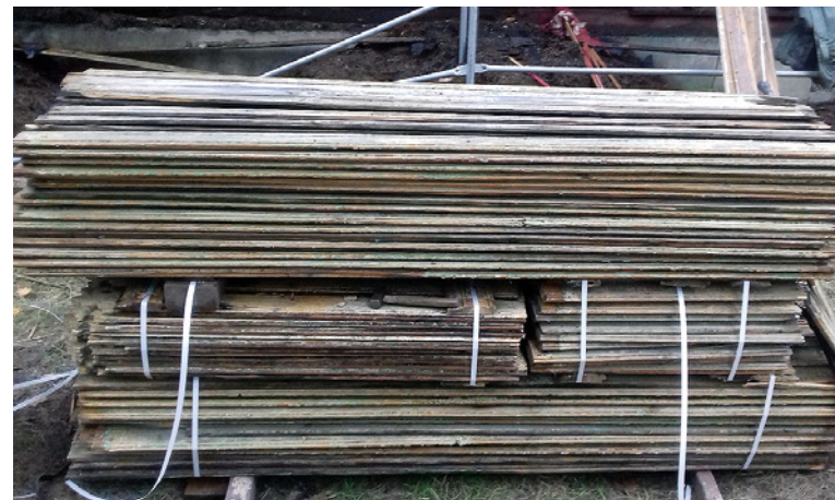
Sposób składowania szalunku po demontażu
