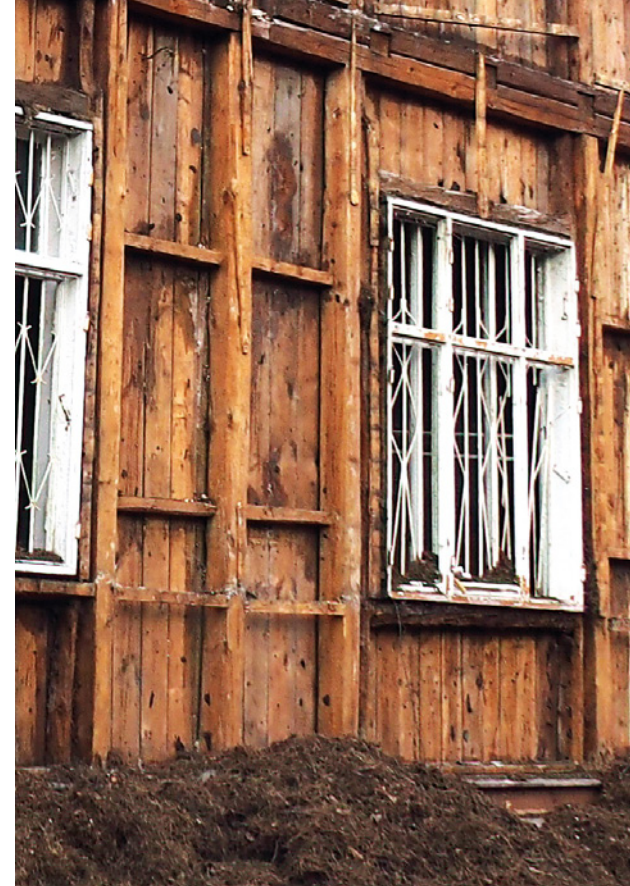
Ściana o konstrukcji szkieletowej po zdjęciu szalunku i usunięciu igliwia
