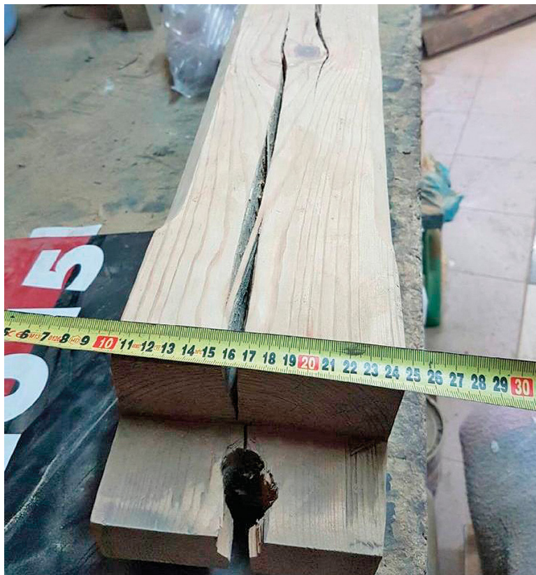
Wzdłużne pęknięcie drewna jest naturalnym efektem jego wysychania – zdarza się bardzo często
