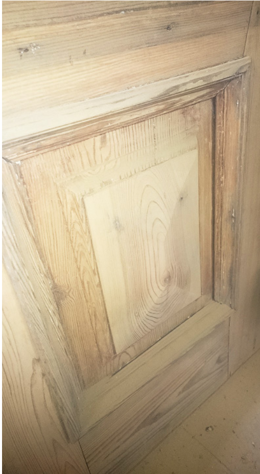
Ponad stuletnie drzwi wejściowe po zdjęciu powłok malarskich
