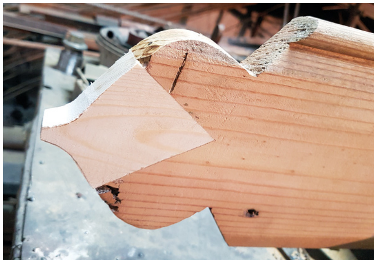
W ten sposób należy uzupełniać ubytki w ozdobnych elementach
