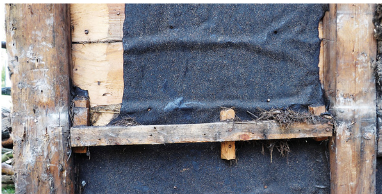
Papa nabijana na wewnętrzny szalunek służyła jako wiatroizolacja
