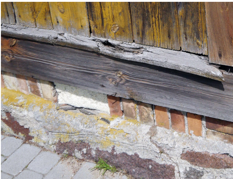
Otwór wentylacyjny zatkany styropianem to częsta przyczyna zagrzybienia drewnianych podłóg
