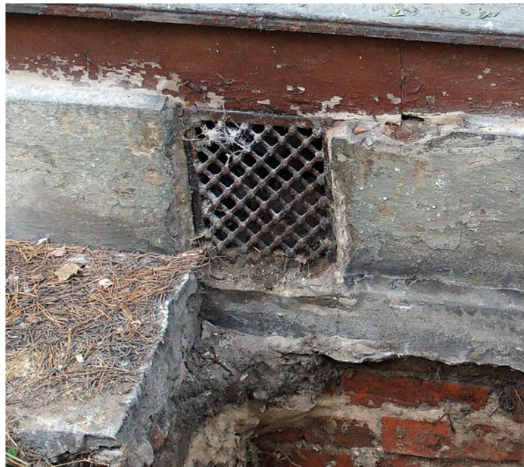
Kratka wentylacyjna umożliwia m.in. pobór powietrza niezbędnego do spalania opatu
